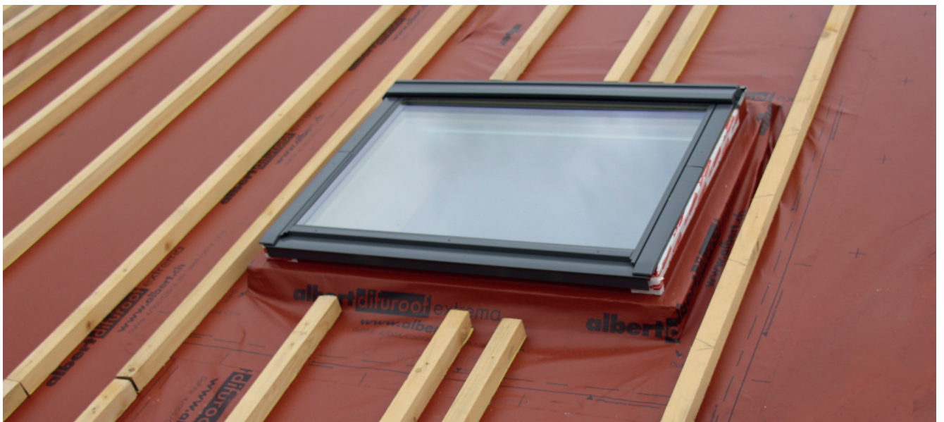
3. Alles mit Heissluftföhn oder Quellschweissmittel homogen verschweissen
