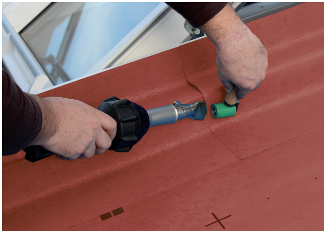
3. Alles mit Heissluftföhn oder Quellschweissmittel homogen verschweissen
