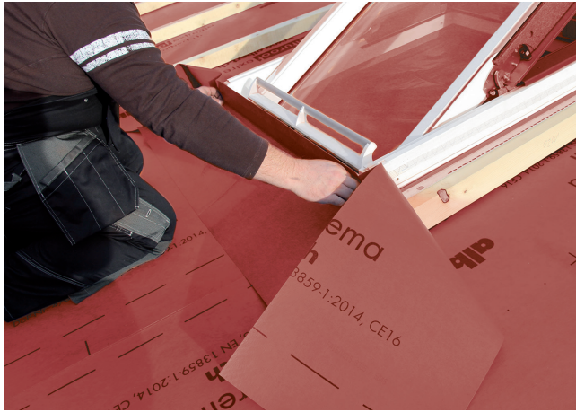
1. Unteres Schürzenteil montieren
