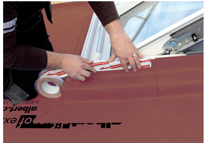
4. Coller le bord supérieur du cadre de la lucarne avec winaco plus
