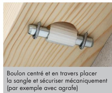
Boulon centré et en travers placer la sangle et sécuriser mécaniquement (par exemple avec agrafe)
